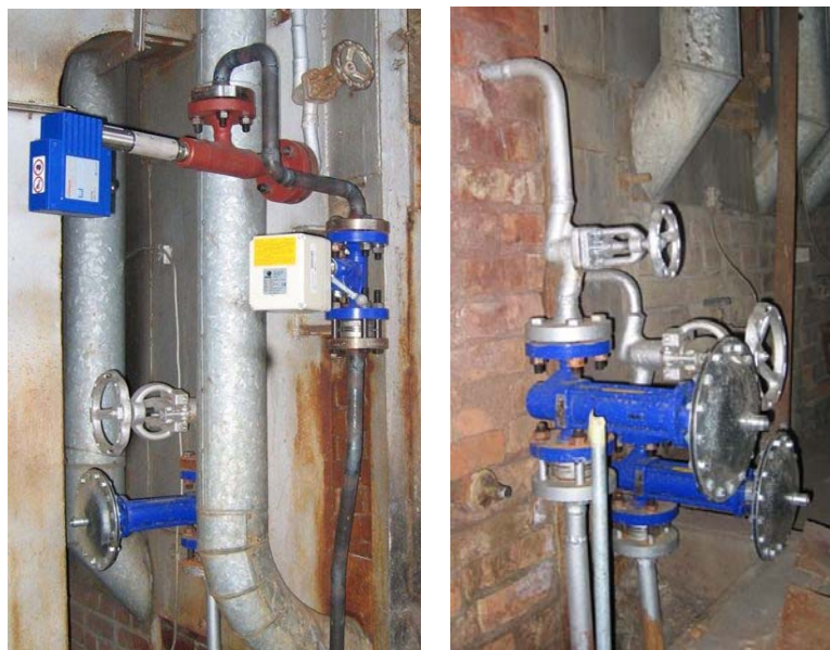
Rys. 15 Modernizacja i automatyzacja systemu odsalania i odmulania na kotle OR 16. a/ pomiar przewodności, zawór odsalający i zawór odmulający komory przedniej b/ zawory odmulające komór tylną i bocznej lewej
